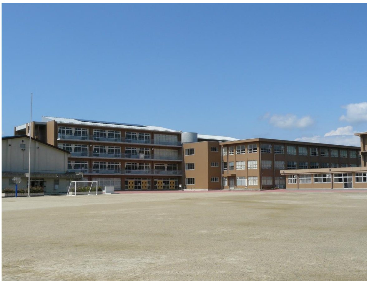
建物外観写真
