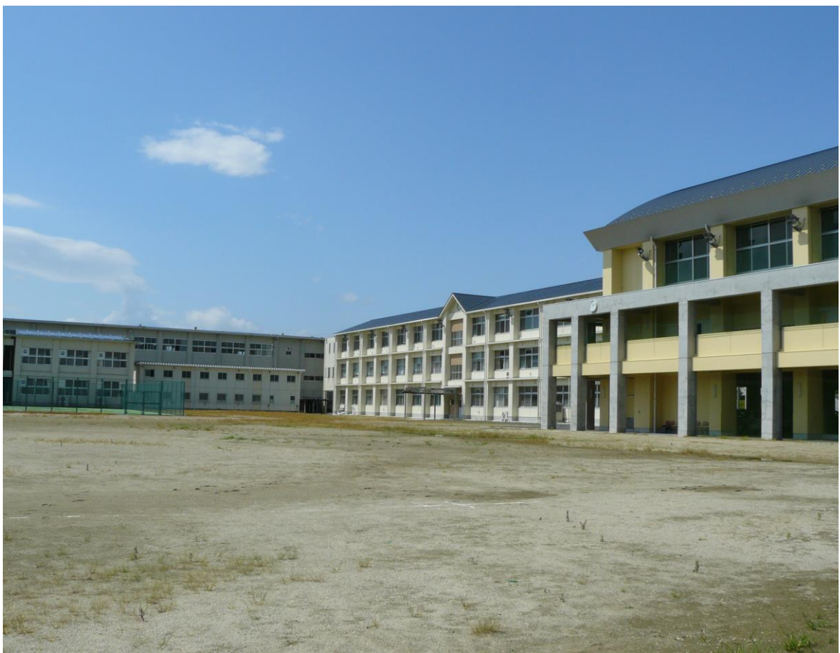
建物外観写真
